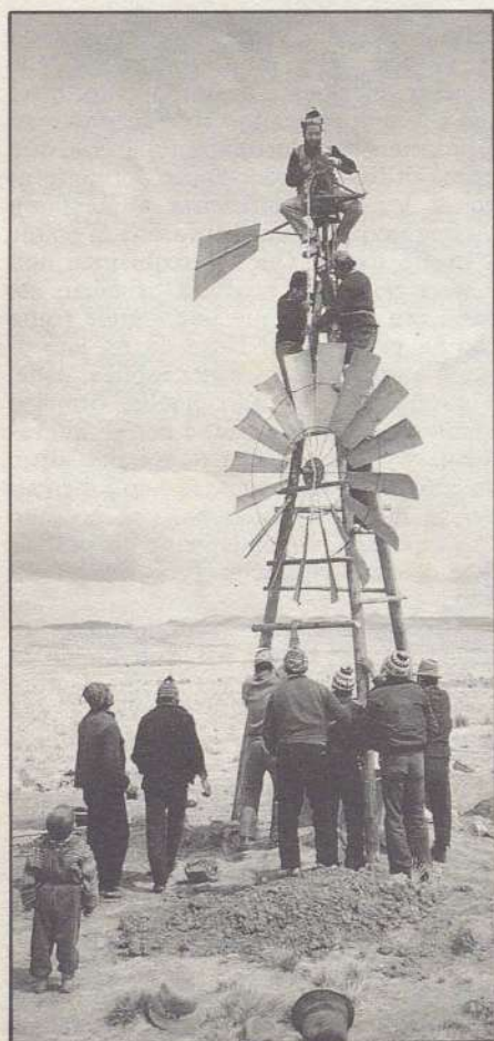
Tecnologia semplice e pulita. Nella foto a sinistra: l'installazione di un mulino a vento per il pompaggio dell'acqua nelle Ande peruviane. A destra: la ruota di un mulino ad acqua in attività a San Vittore Olona, in Lombardia.
